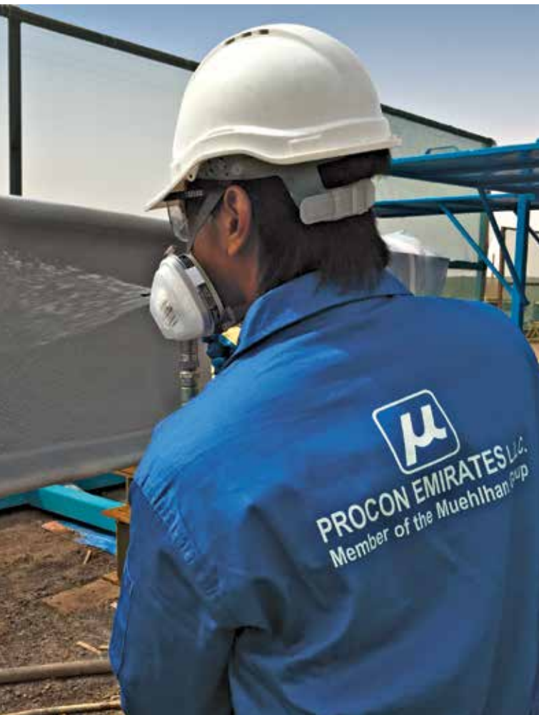
Aufbringen von Brandschutz auf Stahl
