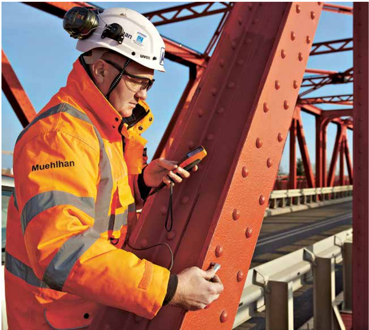
Überprüfung des Oberflächenschutzes einer Brücke
