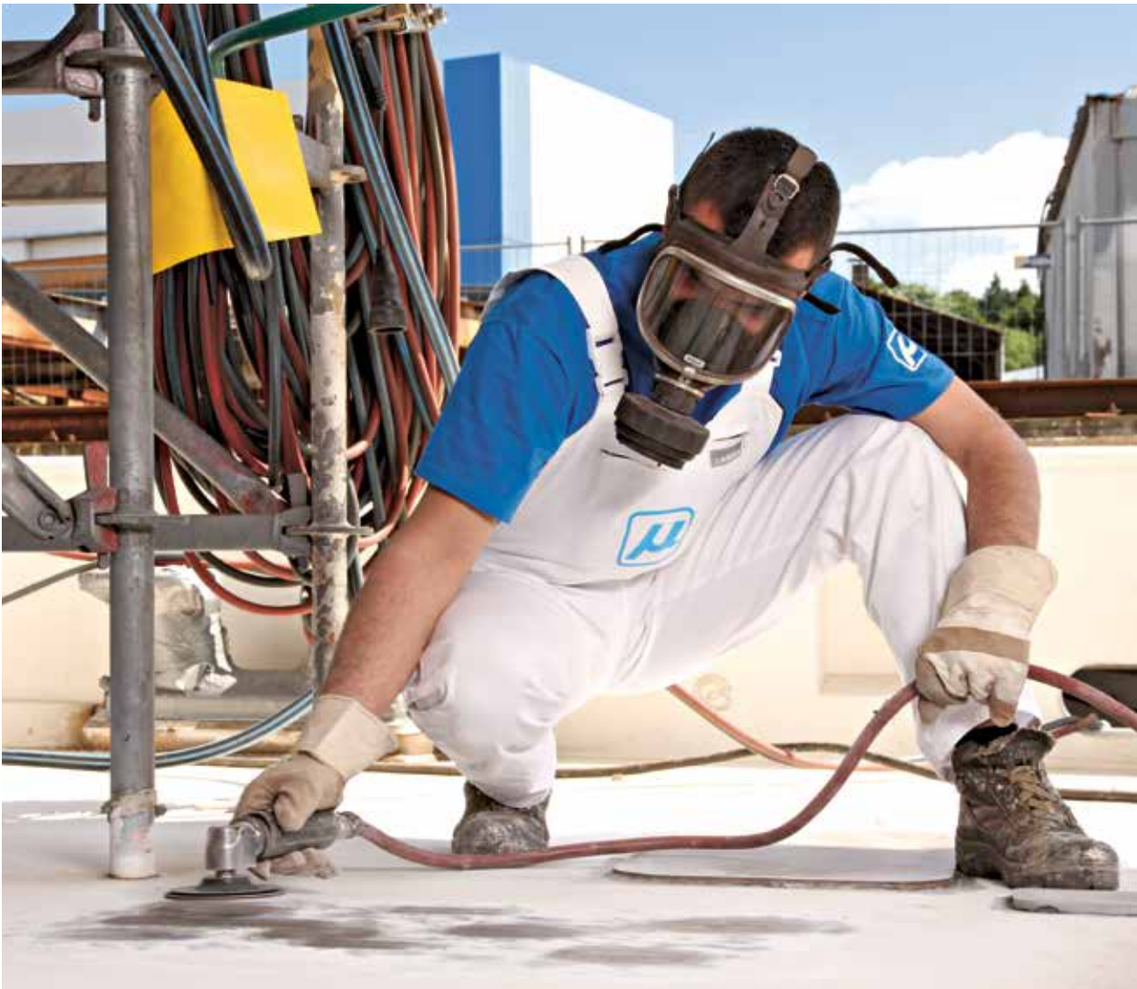
Muehlhan-Mitarbeiter schleift Stahlkonstruktion.
