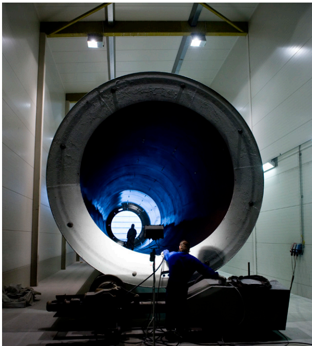
Oberflächenbeschichtung von Turmsegmenten von Windkraftanlagen
