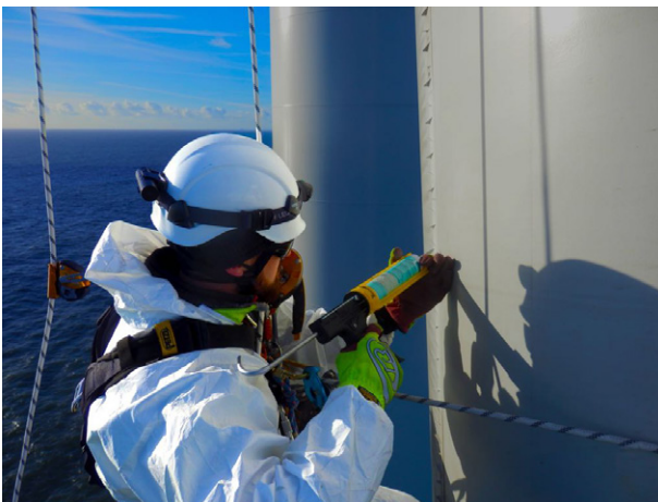
Service-Arbeiten auf Offshore-Windkraftanlage
