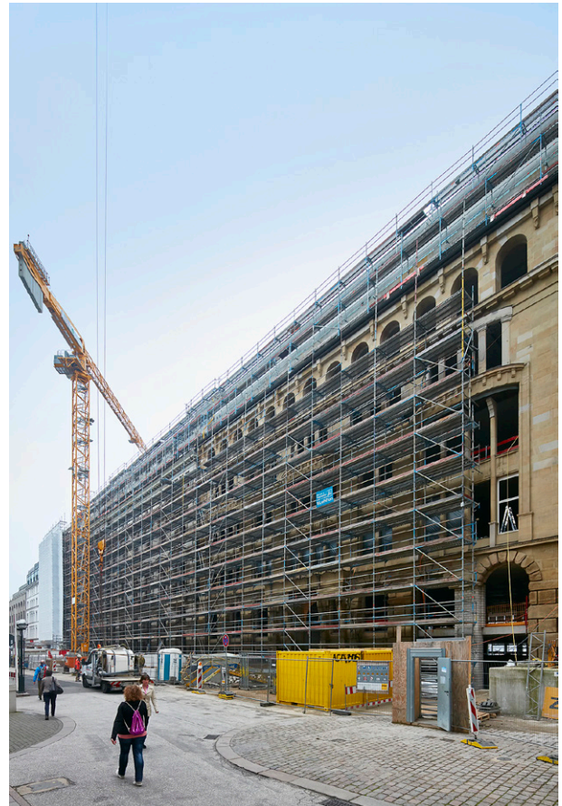
Gerüstbau in Hamburg
