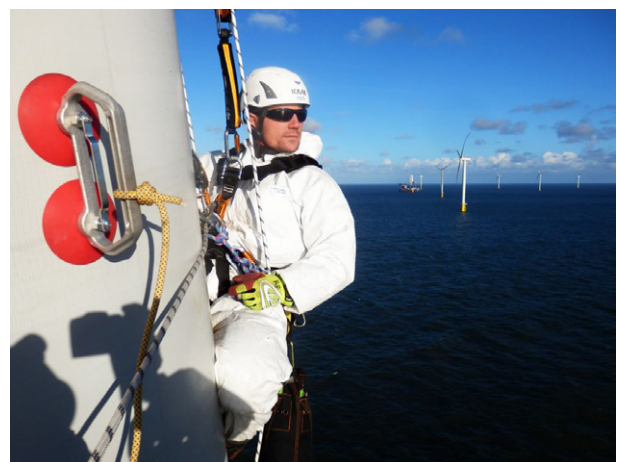
Service-Arbeiten auf Offshore-Windkraftanlage
