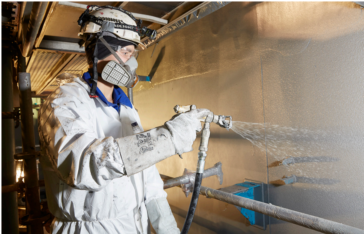
Aufbringen von Brandschutz
